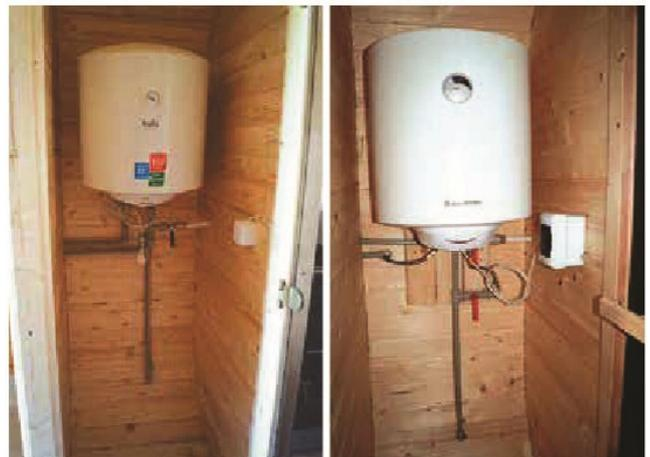
Tank für die Sommerdusche / Tank für die Kaltwasserversorgung der Sauna
